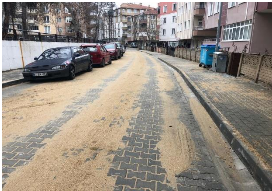
Akat Sokak Beton Parke Taş Döşenmesi
