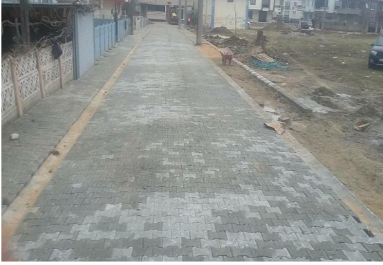
Çırpan Sokak Beton Parke Taş Döşenmesi
