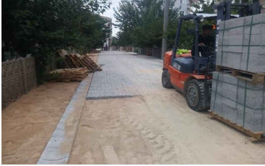
Uçtu 1 Sokak Beton Parke Taş Döşenmesi
