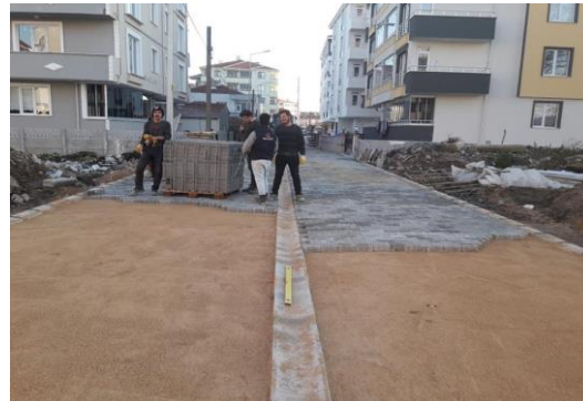
Dere 1 Sokak Beton Parke Taş Döşenmesi
