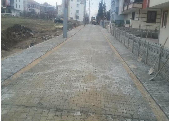
Gönül 1 Sokak Beton Parke Taş Döşenmesi
