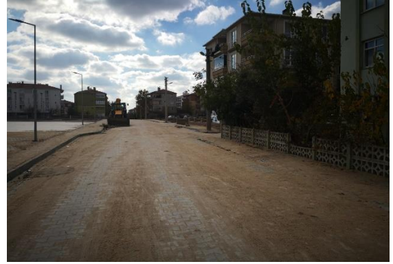
Kent Sokak Beton Parke Taş Döşenmesi
