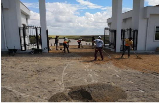
Gülaçar Sokak Beton Parke Taş Döşenmesi
