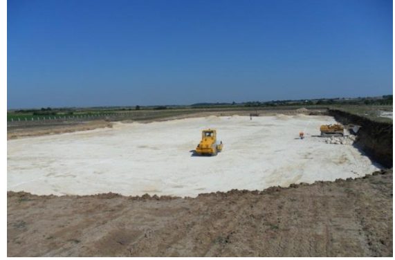
Havalandırma Tankları Temel Altı Dolgusu
