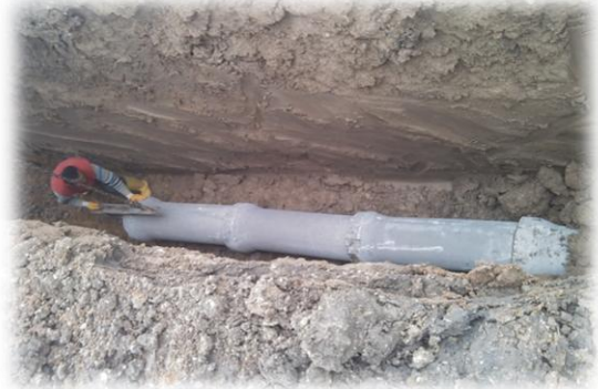
1. BÖLGE KANALİZASYON HATTI DÖŞEME ÇALIŞMASI
