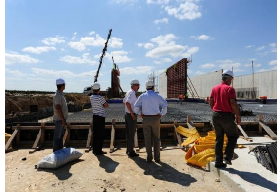
Havalandırma Tankları Beton Dökümü
