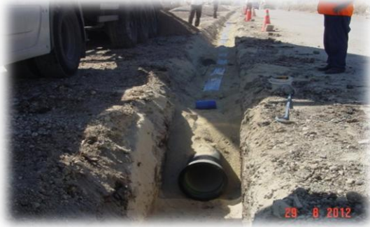
İSTASYON CADDESİ İÇMESUYU DÖŞEME ÇALIŞMASI
