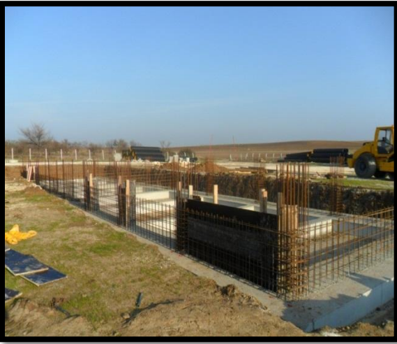
Blower ve Trafo Binası Temeli
