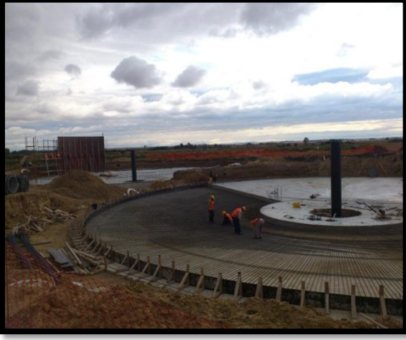
Son Çökeltme Tankları Demir ve Kalıp Çalışması
