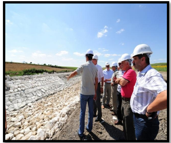
Kavak Deresi Rehabilitasyonu
