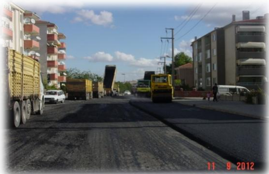
GENÇLİK MAHALLESİ ESKİ İSTASYON CADDESİ
