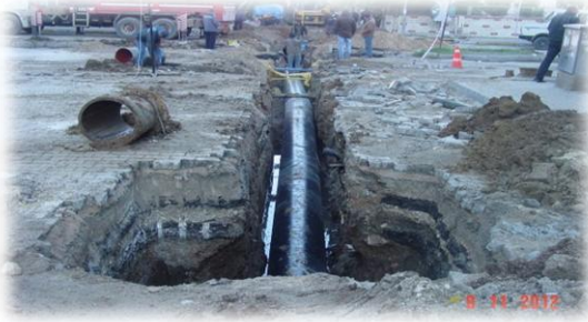
İSTASYON CADDESİ İÇMESUYU DÖŞEME ÇALIŞMASI
