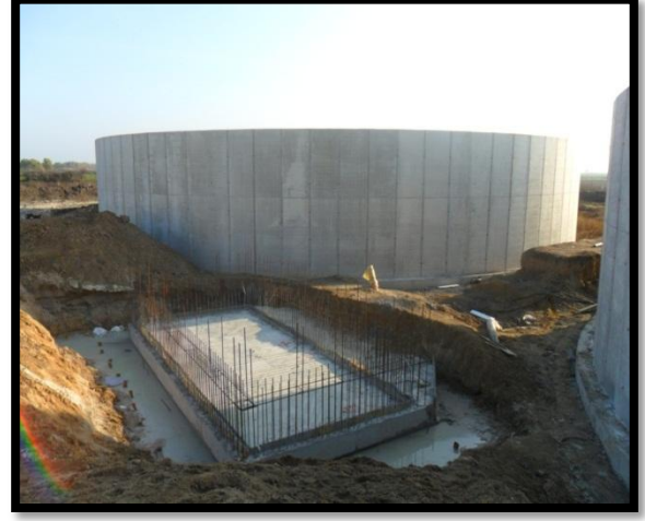
Geri Devir ve Fazla Çamur Pompa İstasyonu
