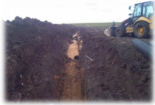
ANAFARTALAR SOKAK YAĞMURSUYU HATTI DÖŞEME ÇALIŞMASI
