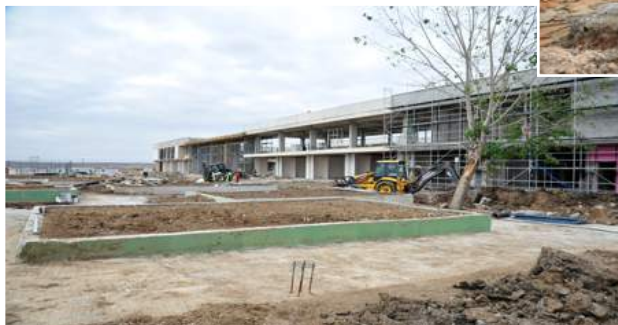
Lüleburgaz Yıldızları Sanat Akademisi İnşaat Alanı
