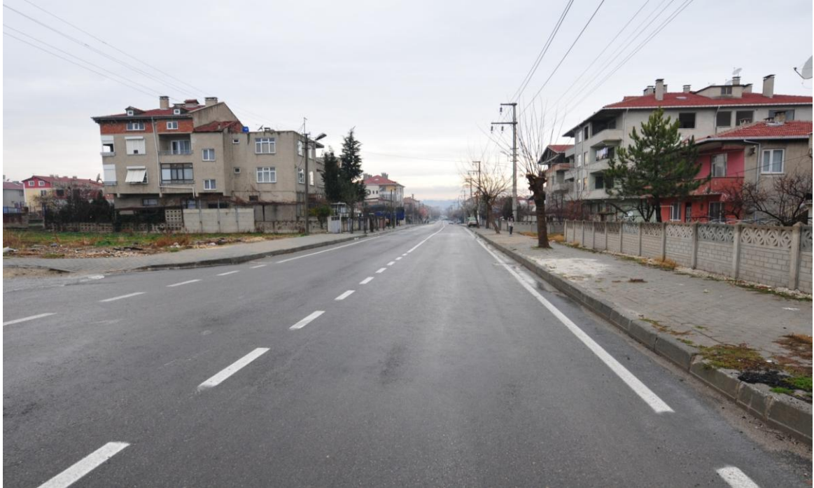
SAKIZKÖY CADDESİ SICAK ASFALT ÇALIŞMASI
