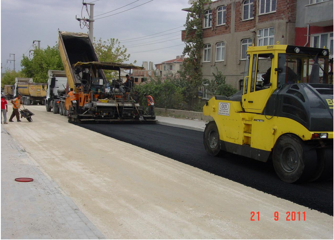
SAKIZKÖY CADDESİ SICAK ASFALT ÇALIŞMASI
