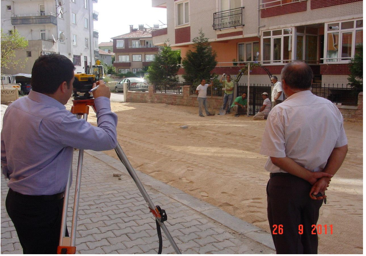
KURTULUŞ MAHALLESİ ECE SOKAK
