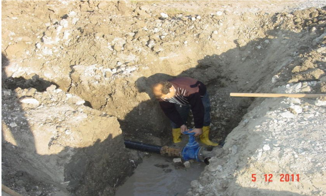
ÇETİN YELMEZ BULVARI İÇMESUYU HATTI ÇALIŞMASI
