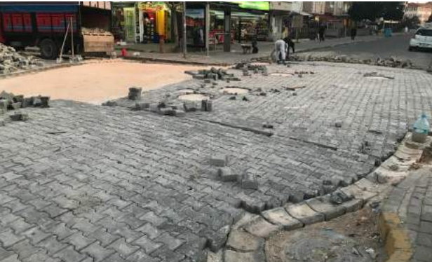
Hürriyet Caddesi Taş Yapım İşi
