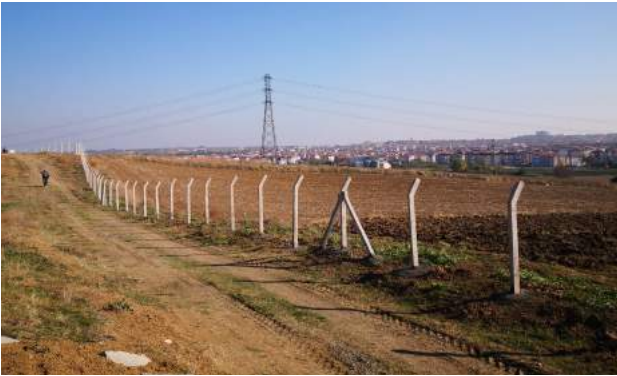
Kent Ormanı Tel Çit Yapım İşi
