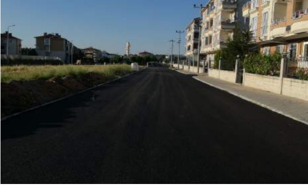
Coşkun Sokak Asfalt Yapım İşi
