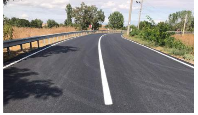
Set Sokak Asfalt Yapım İşi
