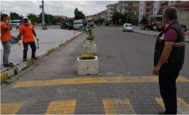
Eski İstasyon Caddesi Yaya Geçitleri Çizilmesi İşi
