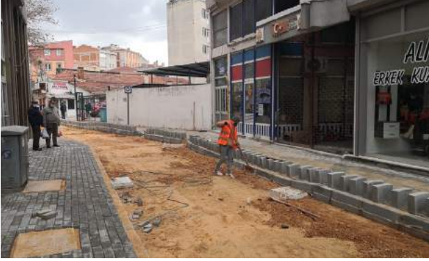
Cihangir Sokak Taş Yapım İşi
