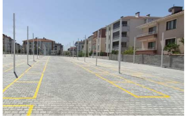
Atatürk Mahallesi Semt Pazarı Taş Döşeme İşİ
