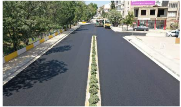
İstiklal Caddesi Asfalt Yapım İşi
