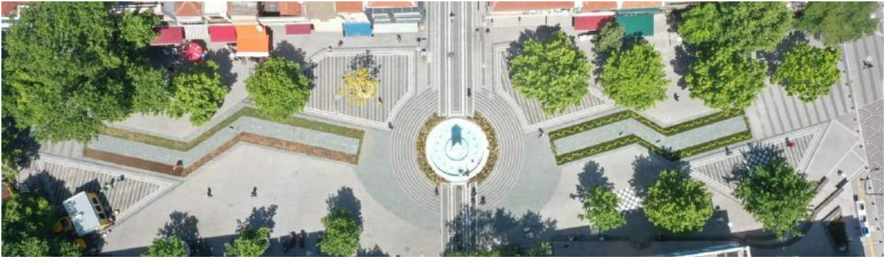
Belediye Meydanı Kuru Havuz Düzenleme Yapım İşi
