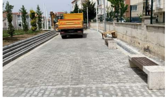
Göktuğ Sokak Taş Yapım İşi
