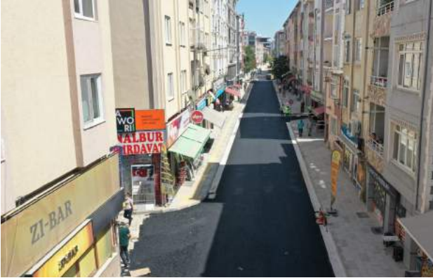
Acı Çeşme Sokak Asfalt Yapım İşİ
