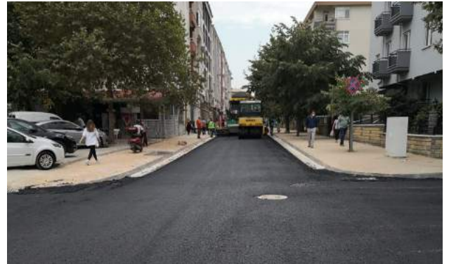
Okullar Caddesi Asfalt Yapım, Kaldırım ve Mantar Taş Çalışmaları
