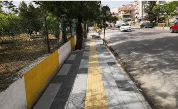
İstiklal Caddesi Engelli Kaldırımı Yapım İşi
