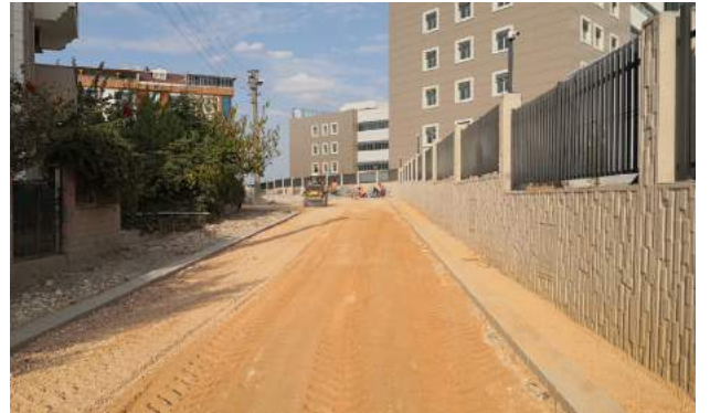
Canan Sok Taş Yapım İşi
