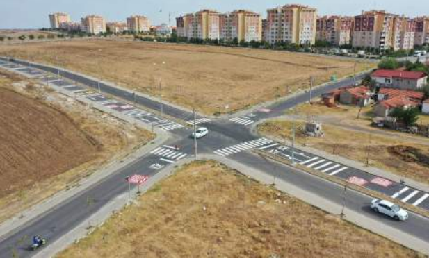
Yaya Geçidi ve Yavaşlama Çizgileri Yapım İşi
