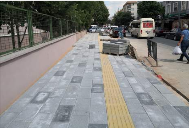
Okullar Caddesi Asfalt Yapım, Kaldırım ve Mantar Taş Çalışmaları
