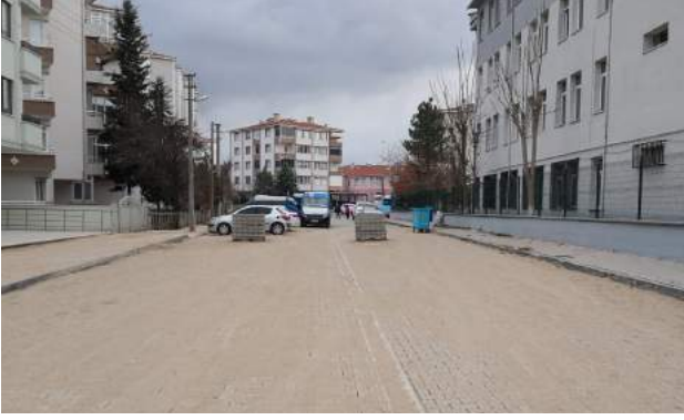
Turgutbey Ara Sokak Taş Yapım İşi
