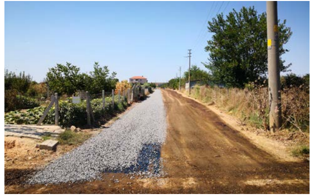
Şehir içi yollarda asfalt ve sathi kaplama yapım işi
