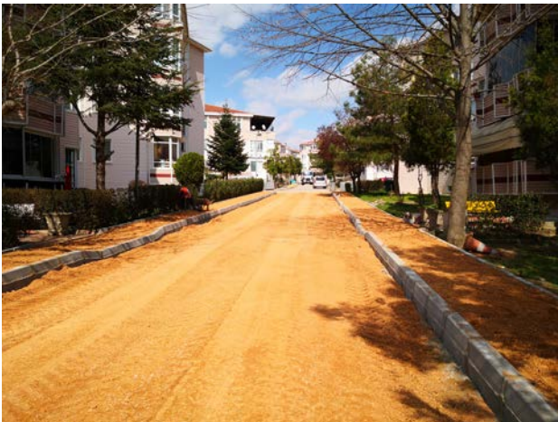
İlçemiz yol ve kaldırımlarında beton parke taş döşenmesi yapım işi
