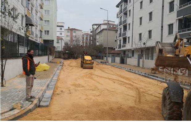
İlçemiz yol ve kaldırımlarında beton parke taş döşenmesi yapım işi
