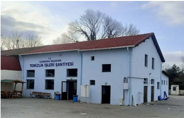
Temizlik İşleri Binası Yapım İşi
