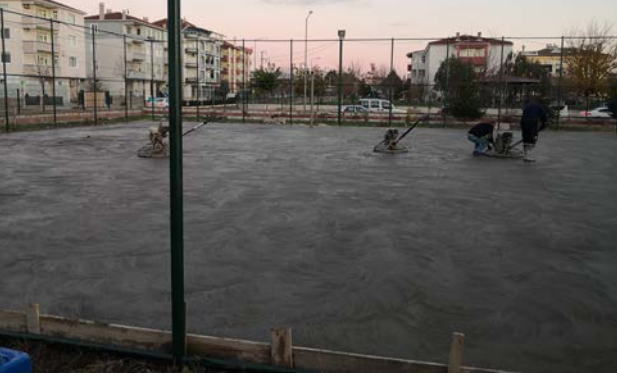
Okullar Hayat Olsun Kapsamında Bakım Onarım Yapım İşleri
