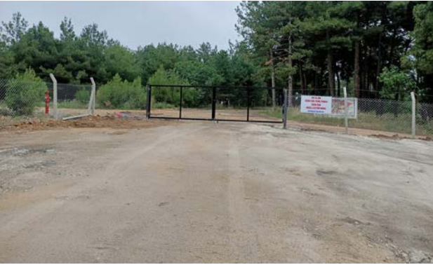
Örme Tel Çit ve Demir Kapı Yapım İşleri (Kent Ormanı)
