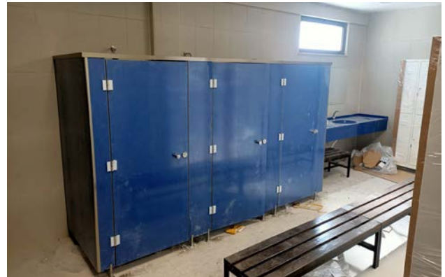
Temizlik İşleri Binası Yapım İşi
