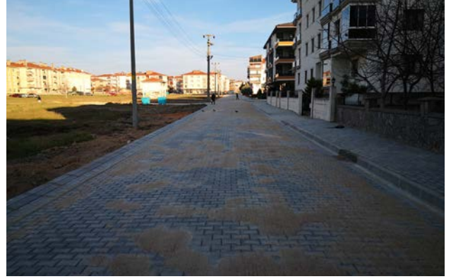
İlçemiz yol ve kaldırımlarında beton parke taş döşenmesi yapım işi
