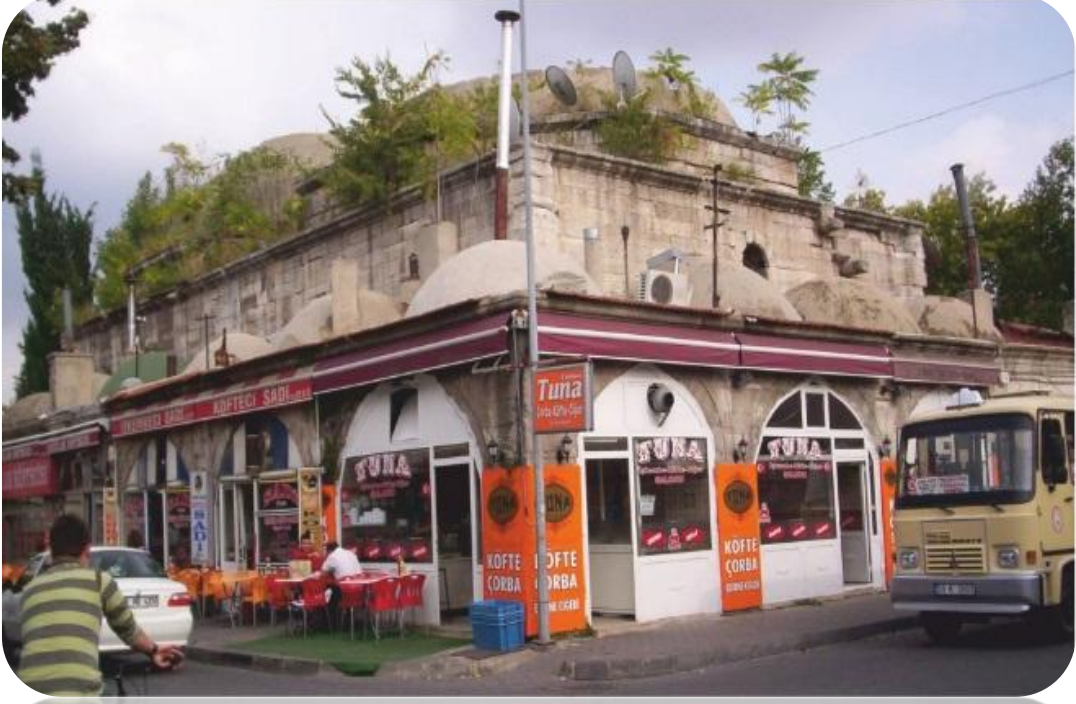
Sokullu Hamamı Restorasyonu
