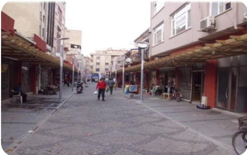
Eski Kırklareli Caddesi Ahşap Pergole Uygulaması
