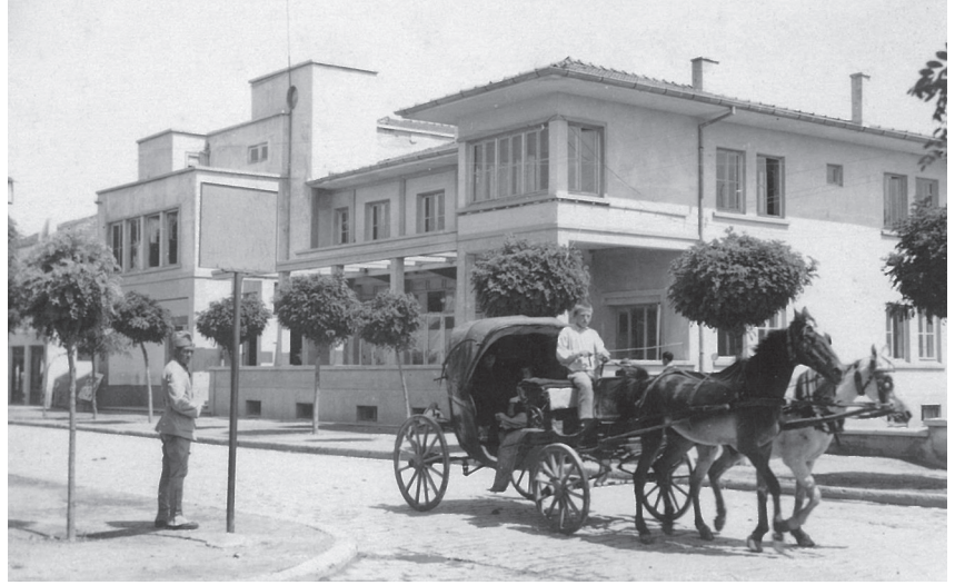
Eski Belediye Hizmet Binası (Mustafa GÜLTEKİN arşivinden alınmıştır.)
